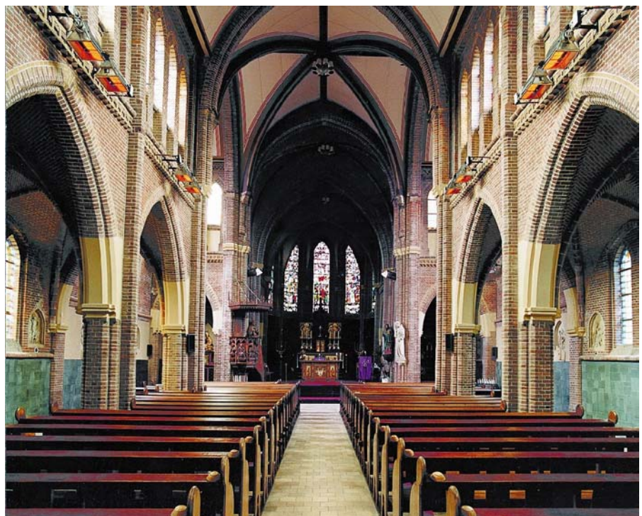
Fig. 01: Calefacción de una Iglesia con radiadores infrarrojos a gas
